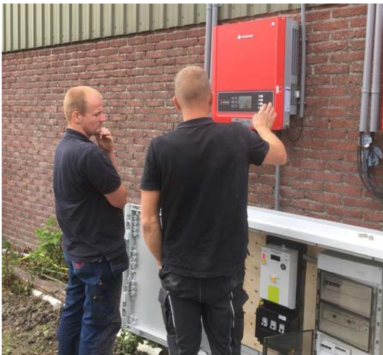
Op de foto stellen de Ten Boerster installateurs de installatie in werking.
